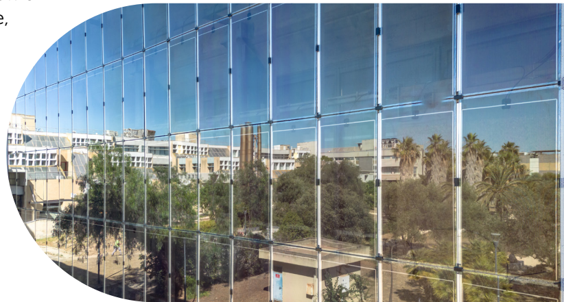
Facciate fotovoltaiche nei blocchi H e G Campus Monserrato
